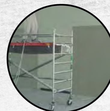
Suchý spad NOXYDE® rozstřík se před dopadem na zem změnil na prášek
